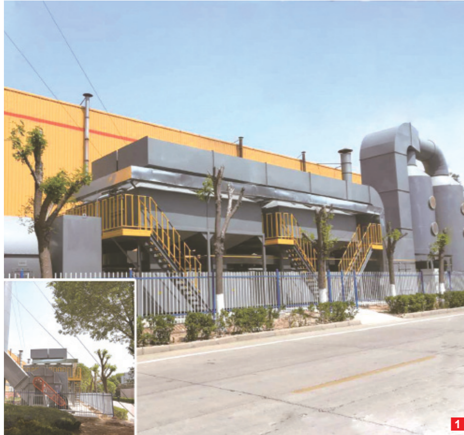
1 中国石油集团济柴动力有限公司 4 套喷漆废气 VOCs 治理项目
